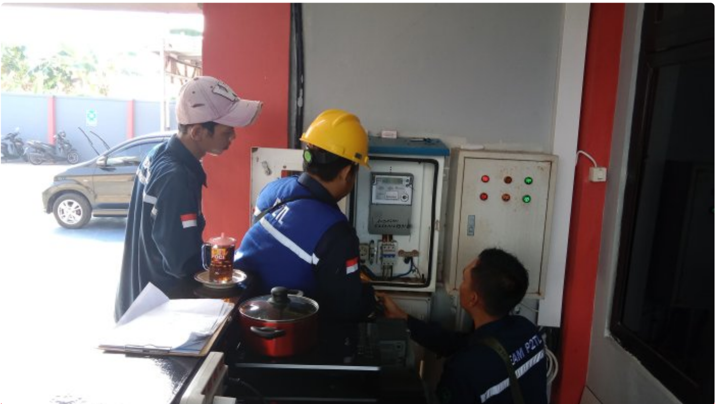
Pegawai PLN Cilacap memeriksa panel listrik di kantor Rupbasan Cilacap
