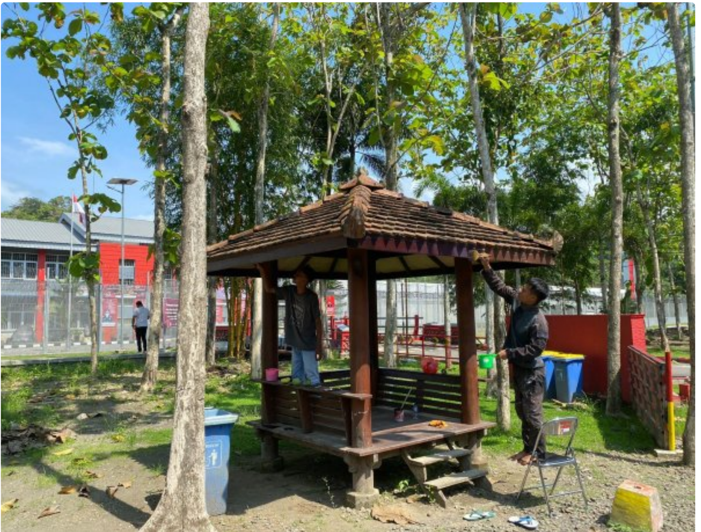
Pengecatan Pos Pengamanan, Dalam Rangka Perawatan Sarpras Lapas Pasir Putih Nusakambangan
